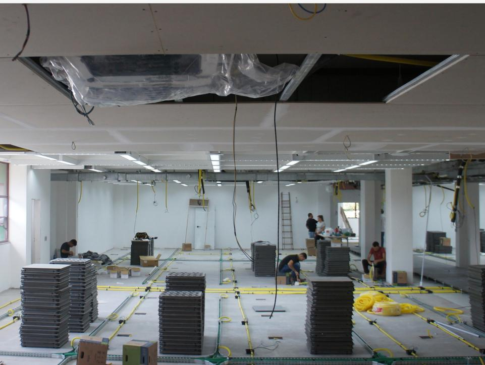
Trabalhadores instalando eletrocalhas e o sistema de ar condicionado central no 1º andar do Bloco I
